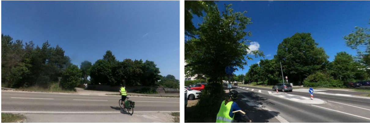
Abbildung 47: Links: Radweg nördlich Industriegebiet Wilburgstetten quert ungesichert die B 25 (DTV 5880 Kfz/24h); Rechts: Mittelinsel zur Überquerung der St 2250 in Rothenburg ob der Tauber vorhanden (DTV = 10994 Kfz/24h)
