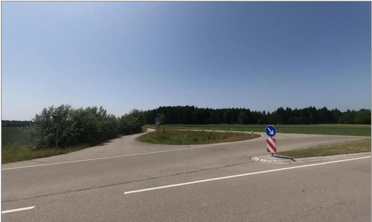
Abbildung 49: Untergeordneter Radweg, obwohl entsprechend der Grenzwerte eine bevorrechtigte Führung vorzusehen wäre (bei Wolfertsbronn)
