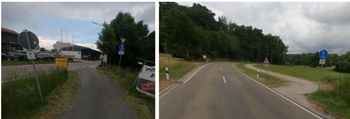
Abbildung 44: Kritischer Übergang zwischen Radweg und Fahrbahn (links: Weihenzell, rechts: Bonnhof)
